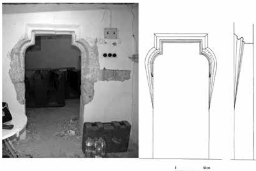
6. A hajó déli kőkeretes nyílásának kutatása és a kapu felmérési rajza Hernádbúd, református templom (Juan Cabello felvétele, 2013; felmérési rajz: Arnóti Zsuzsa)
